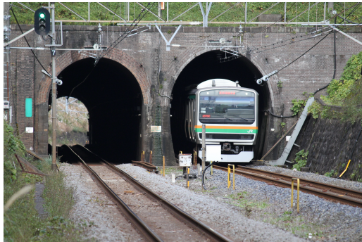
清水谷戸トンネル
