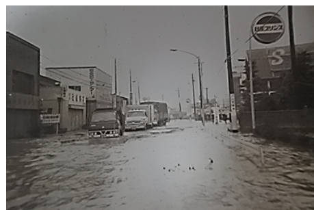
大雨で冠水した前田町付近 (昭和48年11月10日)
