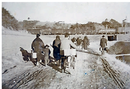
東戸塚地区センター前からの地下道（昭和26年）
