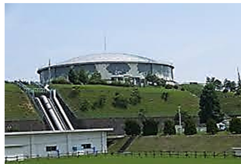
戸塚区小雀浄水場 配水池
