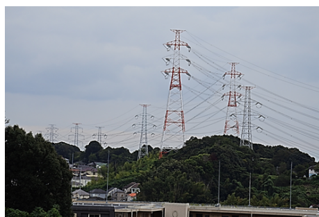
横須賀発電所から上柏尾町上空を伸びる送電線 地表からの高さがあるので、赤白塗布(航空標識)されている
