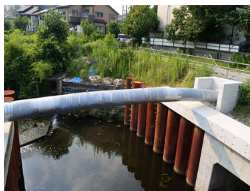
元町橋の架け替えに伴い、水道管も新設された
