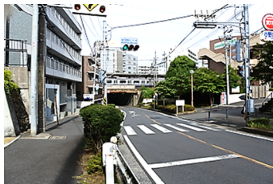
東戸塚地区センター前からの地下道（平成30年）
