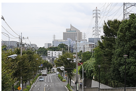
川上町・品濃町から保土ヶ谷方面へ伸びる送電線 写真右の鉄塔
