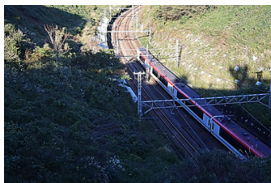
貨物線トンネル出入口 環状2号線から
