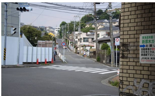
西谷浄水場からこの急坂を下り、戸塚方面へ水道管を埋設した保土ヶ谷区元町橋ガードより
