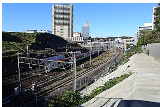
東戸塚駅付近の切通し 信号所があった
